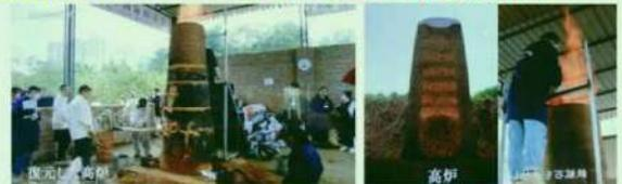
炎で操業管理しつつ、炉頂より鉄鉱石と木炭交互に繰り返し挿入して層状に積み重ねる炉内熔融反応製錬
