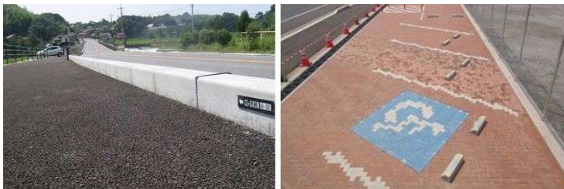
スイコムを使用した道路の境界ブロック（左）と舗装ブロック
