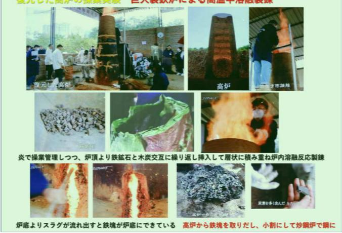
復元した高炉の操作実験 巨大製鉄炉による高温半熔融製錬
