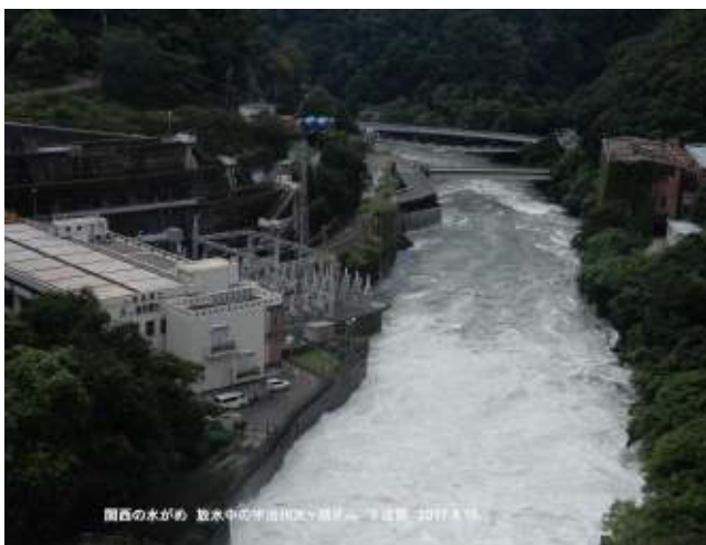
関西の水がめ 放水中の宇治川天ヶ瀬ダム 2017.8.15.
