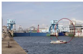
副水門完全閉鎖
