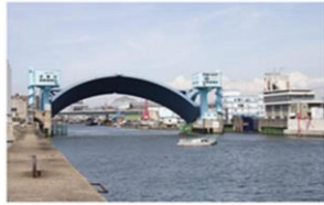
主水門閉鎖作業中
