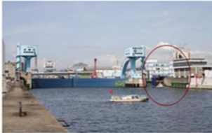
副水門閉鎖作業中
