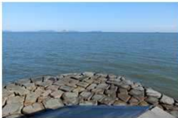
防潮堤突端から家島群島
