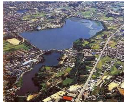
平成の大改修前の狭山池
