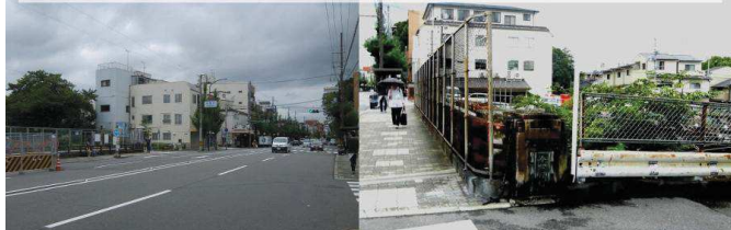
歩きだしてすぐ JR東海道線が潜り抜ける橋がみえ、その向こうに信号がある今熊野の交差点が見えてくる 東山通:東山トンネルを出てきたJR&新幹線が潜り抜ける今熊野橋&今熊野の交差点周辺 2016.9.13.
