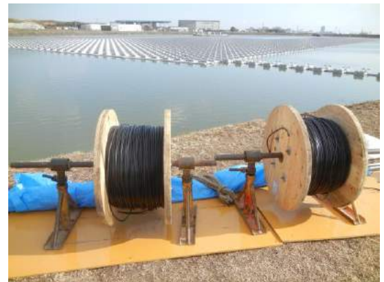
太陽電池/パネル設置ケーブルのリール
