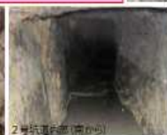
2号坑道内部（南から）
