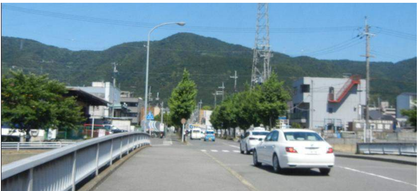
勧修寺横 醍醐道 山科川にかかる橋を渡って 小野駅前へ
