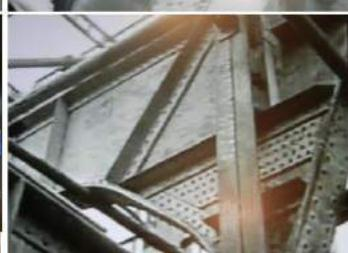
鉄骨構造 リベット継手の現場作業
