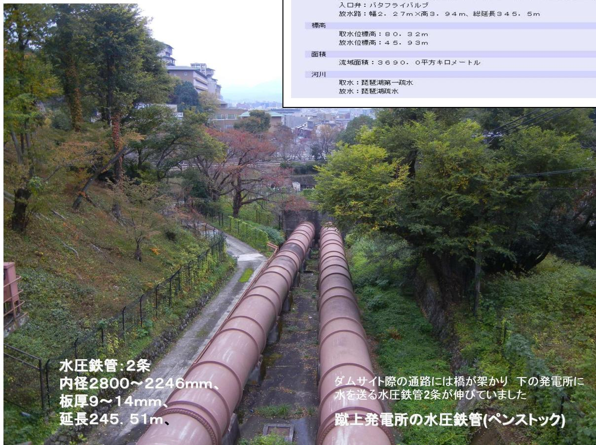
貯水ダムから下の発電所に伸びる水圧鉄管 琵琶湖疎水の建設当時は鍛鉄製鉄接管だったと聞きました
