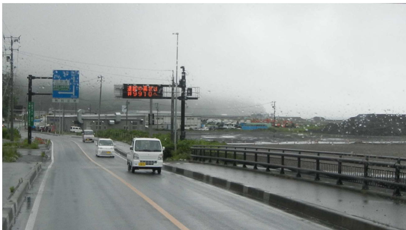
国道 45 号 鶴住居川を渡る 三陸道（大船渡・気仙沼方面無料区間入口）
