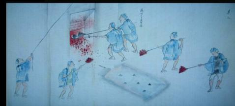
鉄鉄を出し切った後、出鉄口の穴を塞いでいる。
