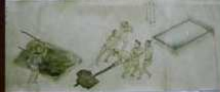
流れ出た鉄を打砕き水たまりに引入れている図
