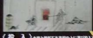
〈投 入〉木炭と鉄鉱石を高炉の上に運び投入する。
