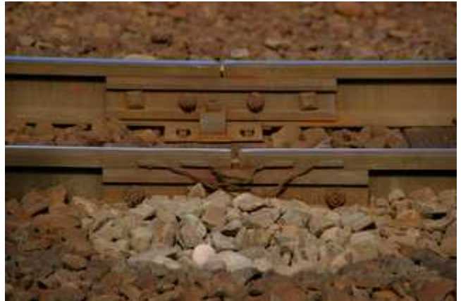
旧レールの継ぎ目
