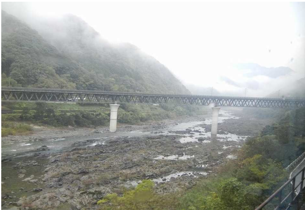
半家駅/十川駅間半家バイパス鉄橋 2013.11.10.
