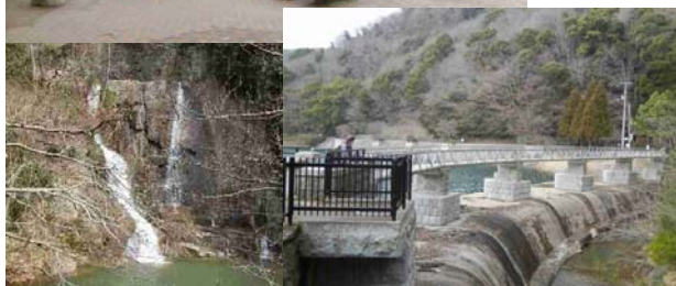
布引谷 布引ダム 五本松堰堤 2013.3.2.
