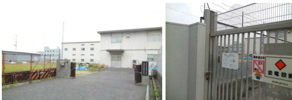
口酒井遺跡 伊丹埋分事務所と変電所がある通り 2012. 12. 21.
