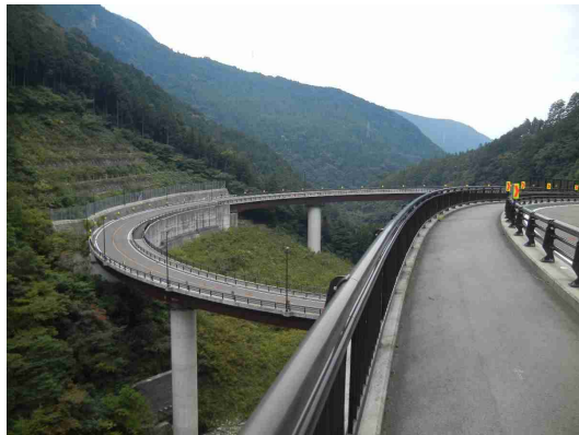
鹿森ダム直下のループ橋 青龍橋 2012.10.27.
