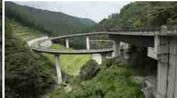
鹿森ダム直下のすぐ下は 傾斜が急なため、 道はループ橋で下ってゆく
