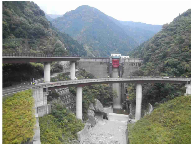
鹿森ダム直下のすぐ下は 傾斜が急なため、 道はループ橋で下ってゆく
