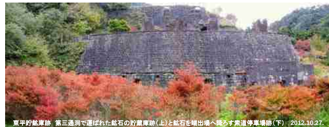
東平貯鉱庫跡 第三通洞で運ばれた鉱石の貯蔵庫跡(上)と鉱石を輸出場へ降ろす索道停車場跡(下) 2012.10.27
