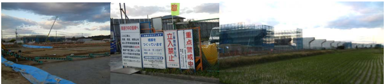
中西遺跡 北側では京奈和道路の橋脚工事がすぐ横まで迫っていました 2011. 11. 255.
