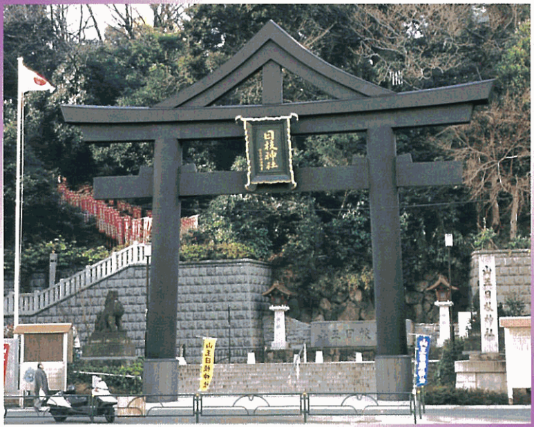
日枝神社(一の鳥居) 平成7年/東京都千代田区 高さ 10.92m/幅 15.73m/柱径 1.0m/柱間隔 8.3m
