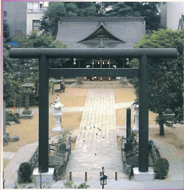
四柱神社(鳥居) 平成12年/長野県松本市 高さ 10.2m/幅 13.3m/柱径 0.8m/柱間隔 8.0m
