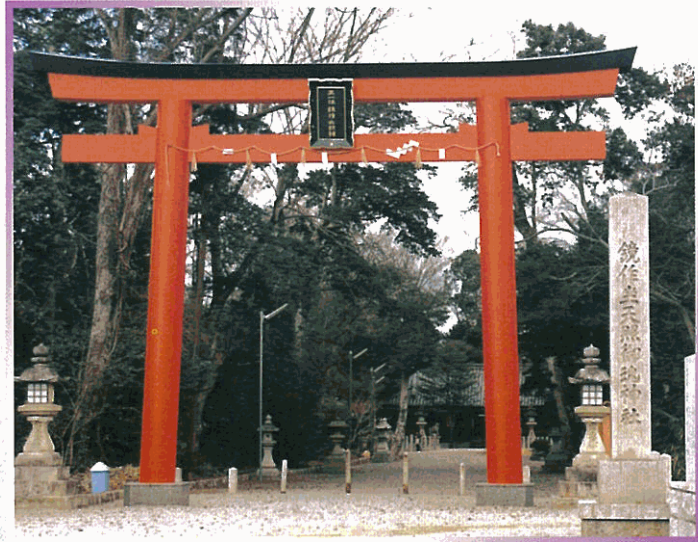
鏡作神社(鳥居) 平成10年/奈良県磯城郡 高さ 8.0m/幅 10.6m/柱径 0.6m/柱間隔 6.0m
