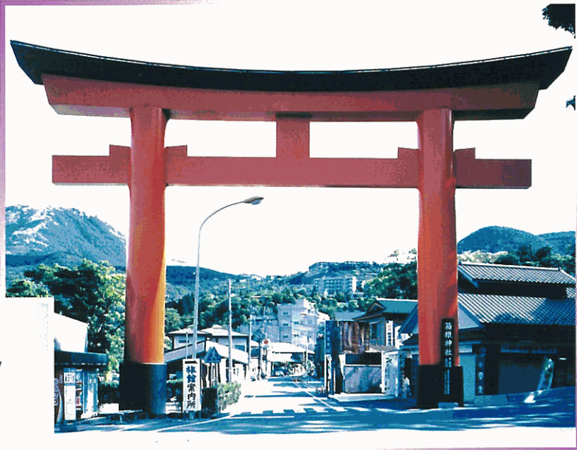
箱根神社(鳥居) 平成5年/神奈川県箱根町 高さ 16.0m/幅 24.1m/柱径 1.7m/柱間隔 13.0m
