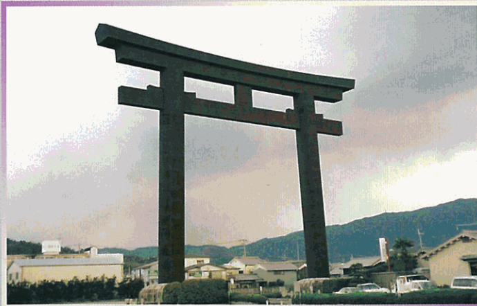
大神神社(第一鳥居) 昭和61年/奈良県桜井市 高さ 32.2m/幅 40.8m/柱径 3.0m/柱間隔 23.5m
