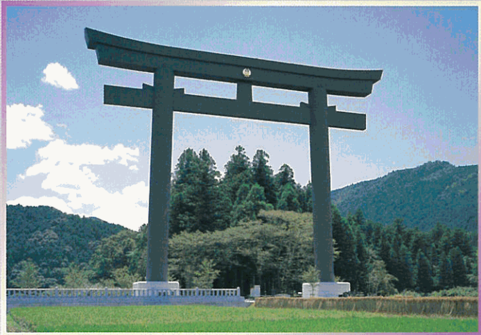
熊野本宮大社(大鳥居) 平成12年/和歌山県本宮町 高さ 33.9m/幅 42.0m/柱径 2.7m/柱間隔 24.5m
