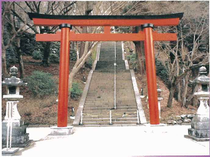
談山神社(鳥居) 平成10年/奈良県櫻井市 高さ 6.0m/幅 8.0m/柱径 0.5m/柱間隔 4.5m
