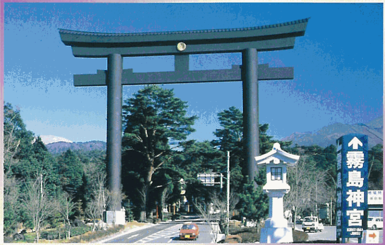
霧島神宮(外参道大鳥居) 昭和63年/鹿児島県霧島町 高さ 22.4m/幅 28.0m/柱径 1.76m/柱間隔 16.0m
