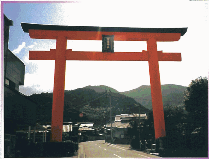
石槌神社(鳥居) 平成6年/愛媛県西条市 高さ 14.6m/幅 20.0m/柱径 1.22m/柱間隔 11.5m
