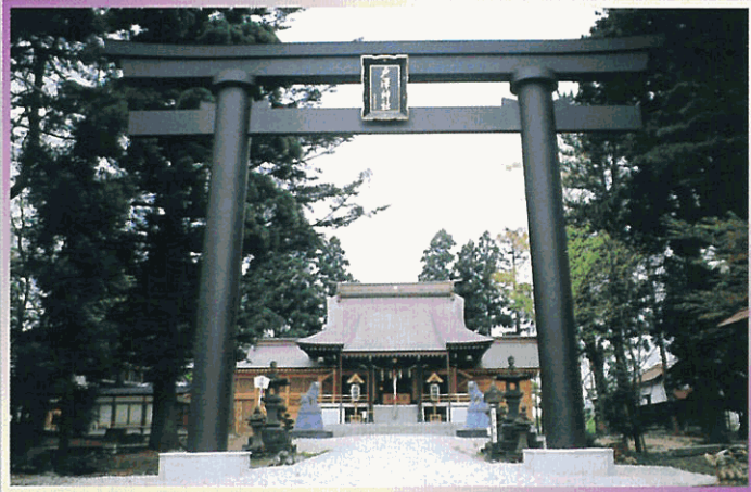
戸澤神社(鳥居) 平成10年/山形県新庄市 高さ 7.3m/幅 9.8m/柱径 0.6m/柱間隔 5.5m
