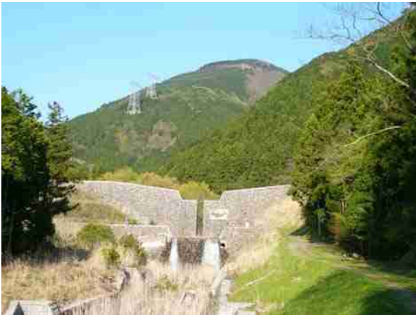
接触変質地帯をまっすぐに流れ下る西明寺川に設けられたスリットの深い砂防ダム堰堤 2010. 5. 2.
