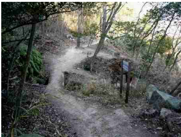
南側城壁 第四水門
