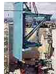
門扉取付状況
