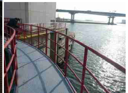
尼崎港第一閘門 水門
