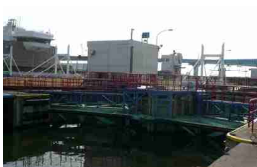
水門の港内側
