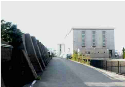
市域を取り囲む防潮堤
