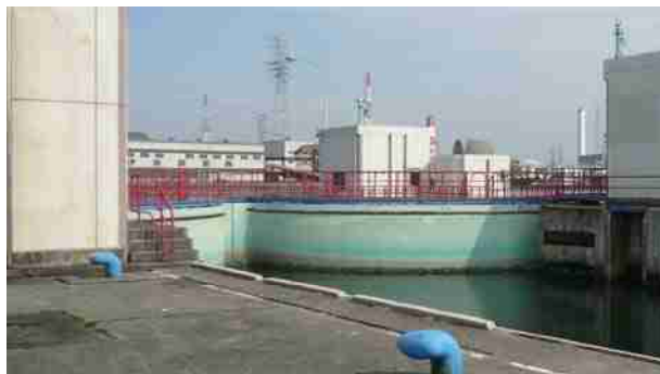
水門の港外側
