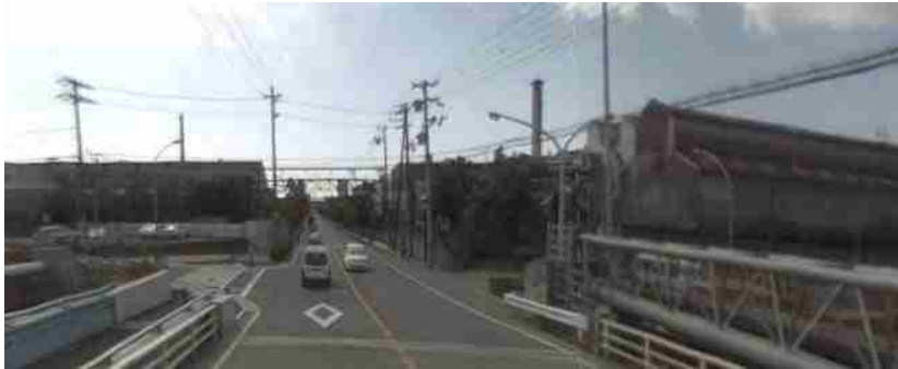
五合橋より南 東向町 住金工場街
