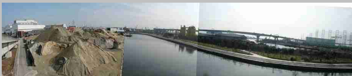
高架橋の東側 運河の左沿い奥が尼崎港閘門 正面が大阪湾を渡る阪神高速湾岸線 右端 パナソニックの大工場
