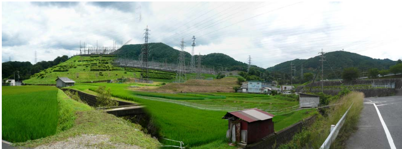
袴腰山の造成地を抜けると北の丘陵地の住宅地と袴腰山の間はのどかな田園地帯 反対の北側丘陵地は住宅地 正面に 袴腰山 その手前に 南郷変電所 右手に岩間山 この周辺が南郷3丁目
