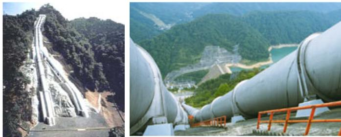
敷設されたペンストック(水圧鉄管)の例 インターネット検索より
