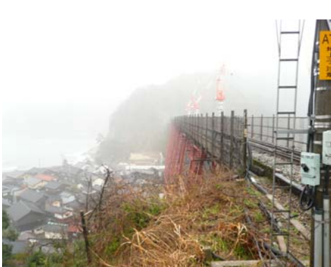
現在の線路・鉄橋に平行して南側(山側)に新しい橋梁がかかるため、駅の南側山腹が切り開かれている 2009.3.25.
