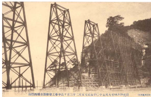
橋桁架設に向けた橋脚間総足場建築
