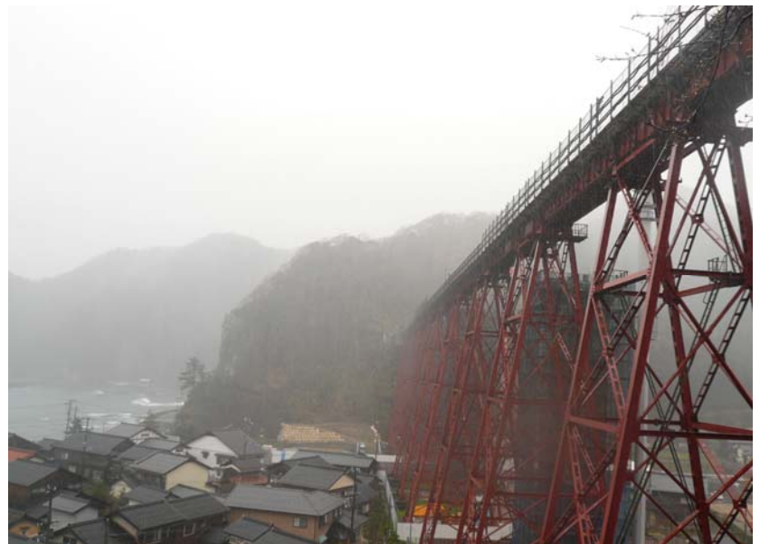
余部の集落の上を渡る山陰線余部鉄橋 2009. 3. 25.
