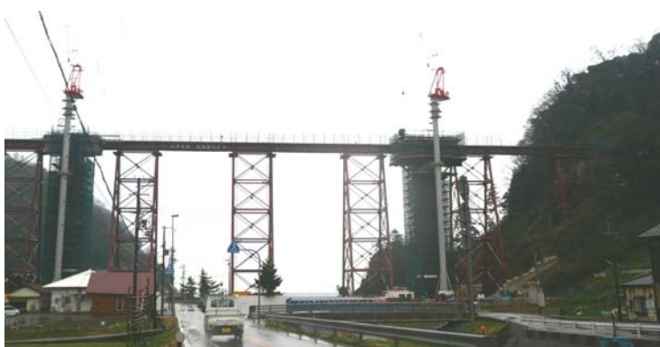
平地の中心部 北の海岸部へ鉄橋をくぐる国道より
