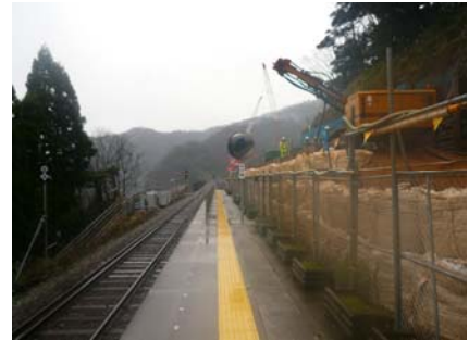
現在の線路・鉄橋に平行して南側(山側)に新しい橋梁がかかるため、駅の南側山腹が切り開かれている 2009.3.25.
