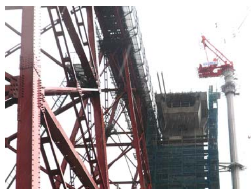
新コンクリート橋梁建設中の橋台路盤部
