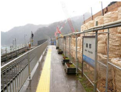
現在の線路・鉄橋に平行して南側(山側)に新しい橋梁がかかるため、駅の南側山腹が切り開かれている 2009.3.25.
