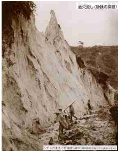
鉄穴・切羽 砂鉄採取
