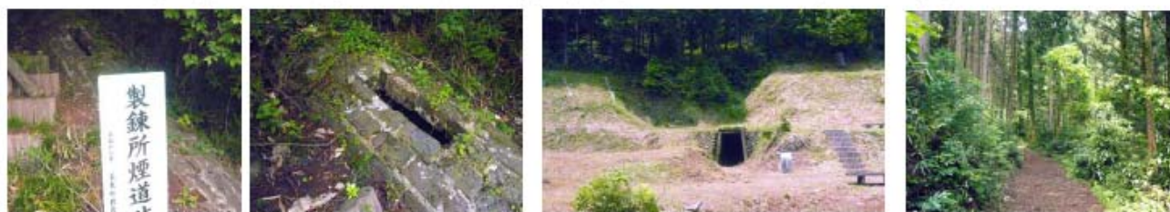
上段部 溶銅炉煙道
