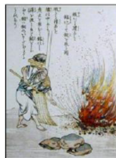
a. 焼炉加熱による酸化銅成分と 銅スラグとの分離 江戸期の銅製錬技術(銅子銅山)
