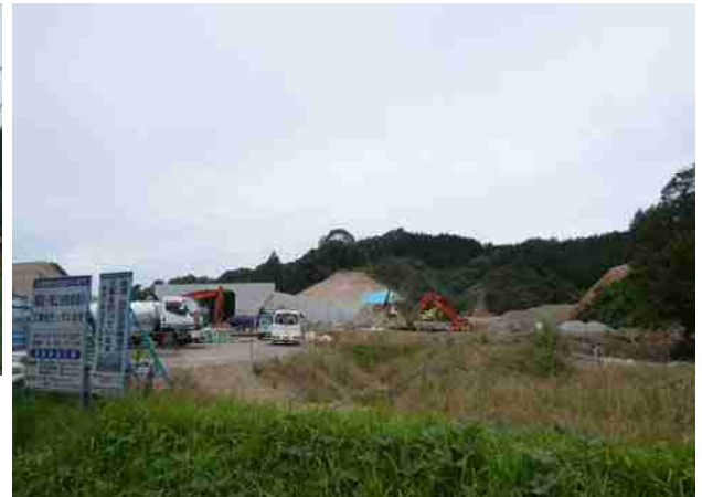
三刀屋六重の松江道工事現場
