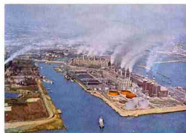
1964年 関西電力 第一・第二発電所
