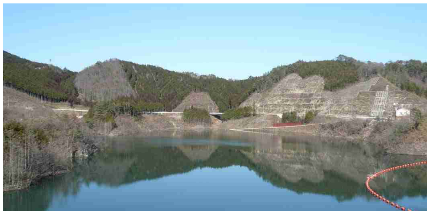
ダム湖に沈んだ大成山たたら湖をダム湖の西側から見る 正面湖面に遺跡がある 右端がダム事務所
