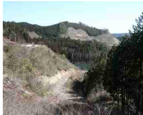
① 下に旧道が顔を出している
