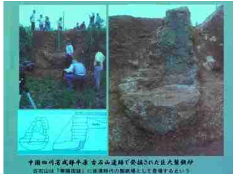
中国四川省で発掘された古代製鉄炉 部分
