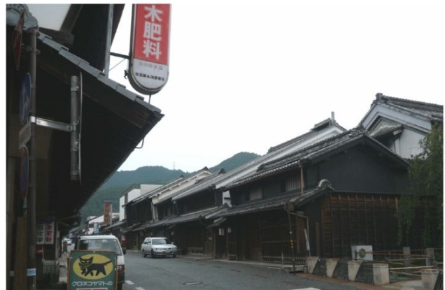
「うだつ」のあがる町並み「美濃」重要伝統的建築物群保存地区 2007.9.10.
