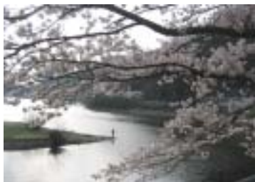
桜の吞吐ダム
