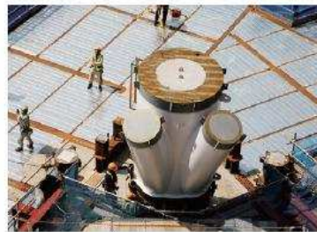
図4●塔体最下部に使用された鋼管 建築現場に納入するには、分岐する鋼管をあらかじめ溶接・塗装した状態で運び込む。(写真：大林組)
