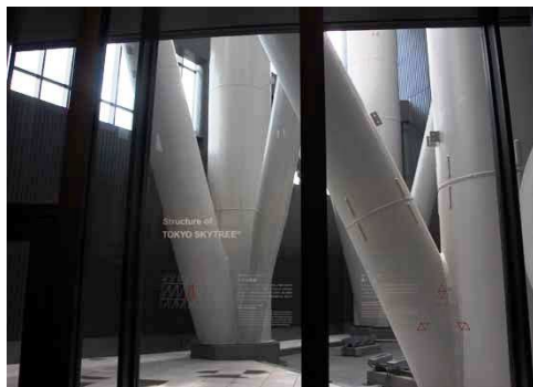
図4●塔体最下部に使用された鋼管 建築現場に納入するには、分岐する鋼管をあらかじめ溶接・塗装した状態で運び込む。(写真：大林組)
