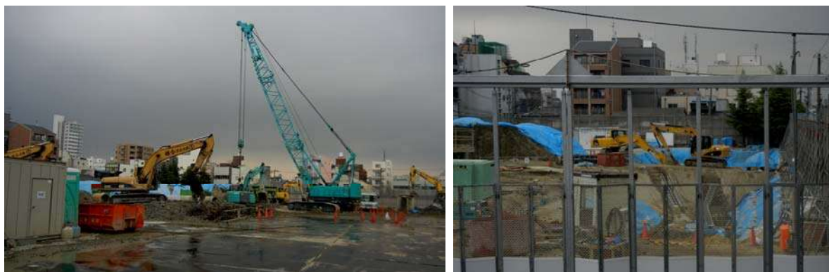
工事現場 中央王通り正面より 左奥が出土地
