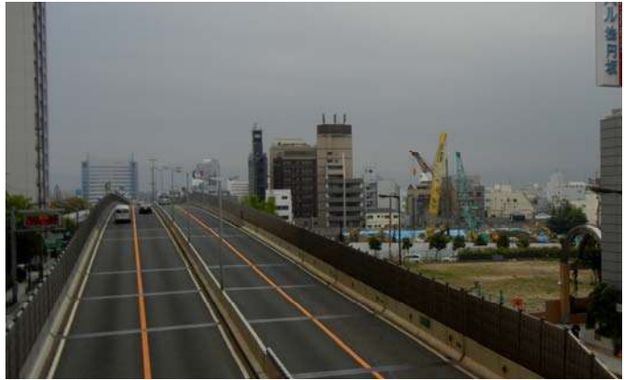
中央大通りより鍛冶工房が出土した工事現場を見る
