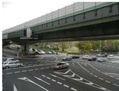
法円坂交差点 北西歩道橋より
