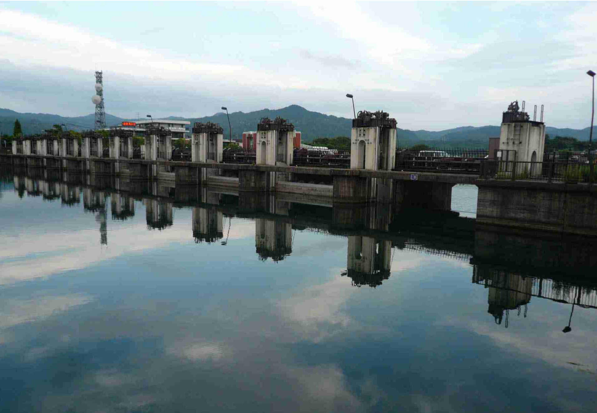
湖南アルプスを左手に 瀬田川 南郷洗堰（上流側） 2009.7.12.
