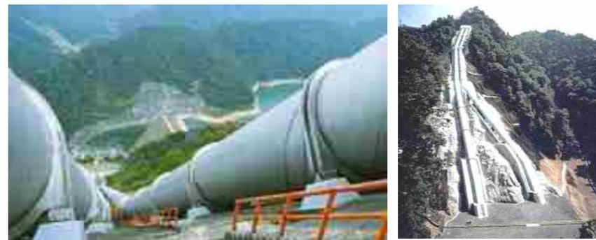
水圧鉄管の例 インターネット検索より
