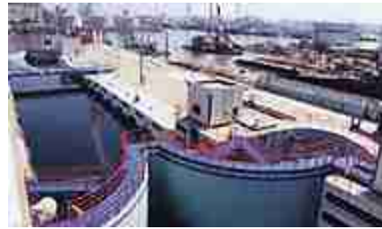
新第2閘門（平成6年度完成）
