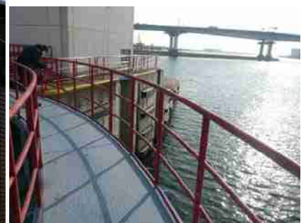
尼崎港第一開門 水門
