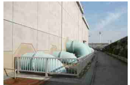
排水場 海への巨大排水管
