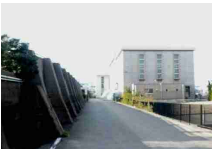
市域を取り囲む防潮堤
