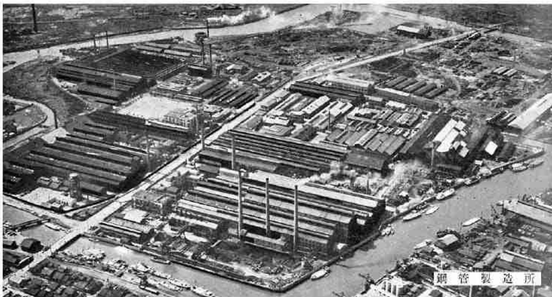
「鉄の街」尼崎昔 (1) 昭和 32 年当時の 住友金属钢管製造所の三本煙突
